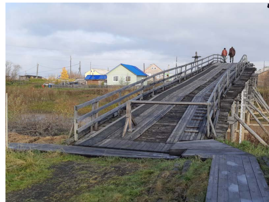
Общий вид проезжей части
